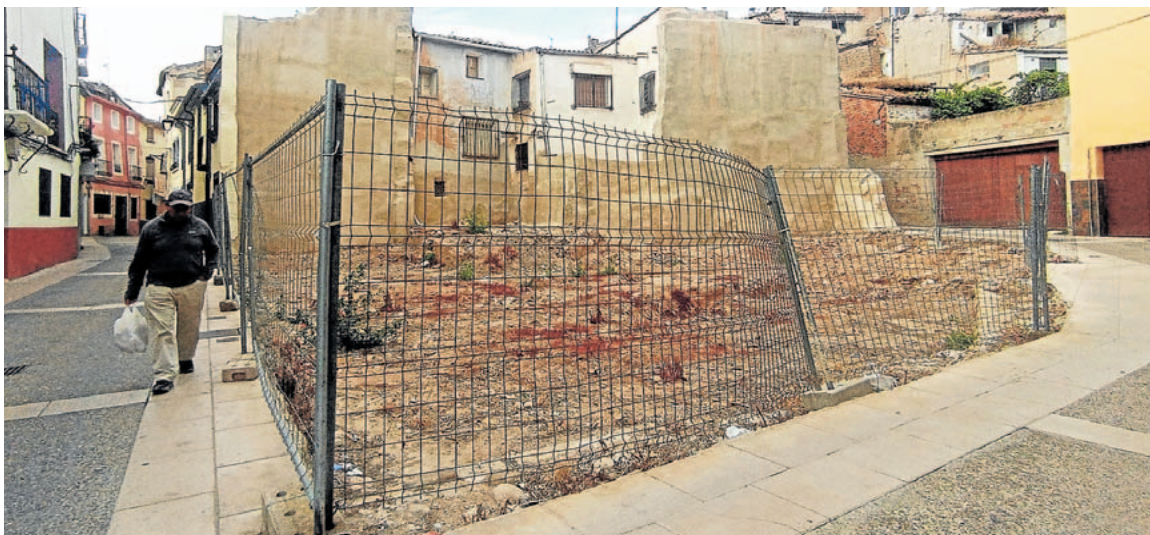
Solar vacío y vallado en la calle San Andrés. I. A.
