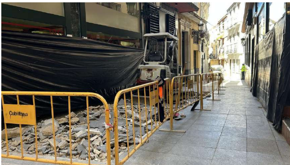
Las obras para levantar el actual pavimento en la calle Virgen de la Soledad comenzaron ayer.
