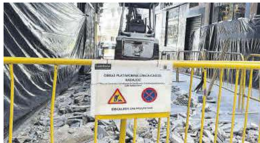
Trabajos de demolición del pavimento de la calle Virgen de la Soledad.
